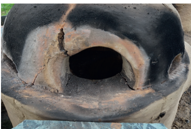
Abb. 8: Kuppel des Schmelzofens vor der Reparatur.
