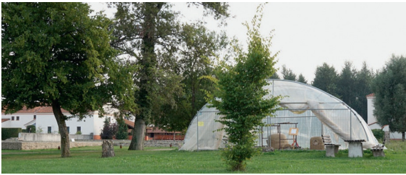
Abb. 5: Tunnelzelt während der Bauphase.
